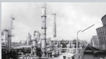
Naphtha cracker (Kurashiki, Okayama, Japan)
