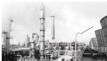
エチレンプラント(岡山県倉敷市)
