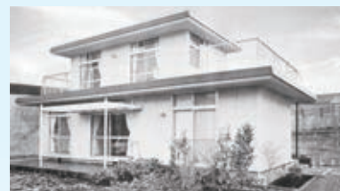
「ヘーベルハウス™」第1号棟(蒲田住宅展示場)
