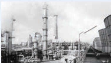
エチレンプラント(岡山県倉敷市)
