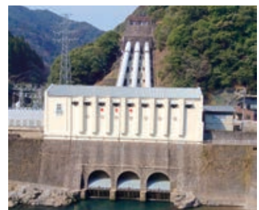
五ヶ瀬川発電所 全景
