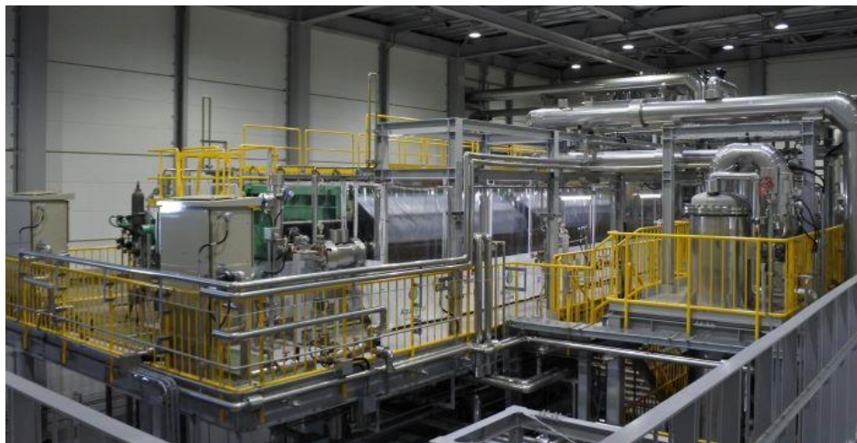
福島水素エネルギー研究フィールド（FH2R）にある 当社の大型アルカリ水電解システム
