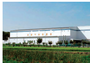
新アフェレシス工場外観
