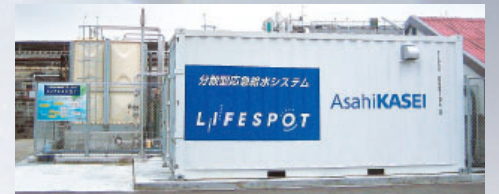
浄水装置や水質自動分析装置を内蔵したコンテナユニット「LIFESPOT」(延岡支社)
