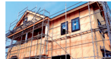
高性能フェノールフォーム断熱材「ネオマ™フォーム」の外張り断熱工法例
