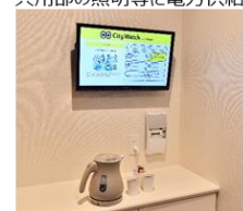
停電時に共用部の防災サイネージや非常コンセントに電力供給。スマホの充電や電気ケトルでの湯沸かしなどが可能。
