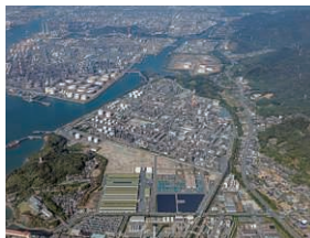
写真：水島製造所
