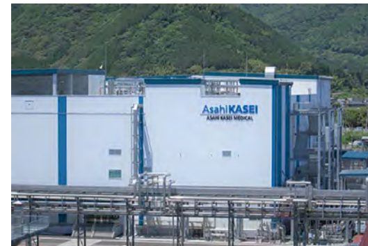
2024年5月竣工の組立工場外観
