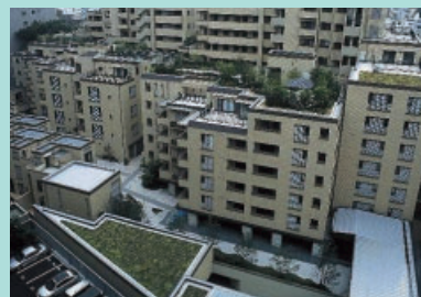
建替え後の同潤会江戸川アパートメント
