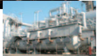
温室効果ガスの一つである亜酸化窒素(N<sub>2</sub>O)の分解装置(ナイロン原料の製造工程)
