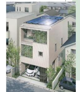
旭化成ホームズは、都市型中層住宅向けの新商品「ヘーベルハウスフレックス G3」を発売しました。システムラーメン構造を採用することにより、耐力壁による間取りの制約を受けない大空間を実現できます。
