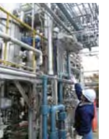
メタルズ設備点検の様子
