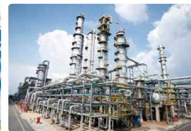
AN新工場外観
