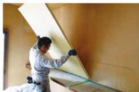
既存壁の内側から「ネオマ断熱ボード」の取り付け
