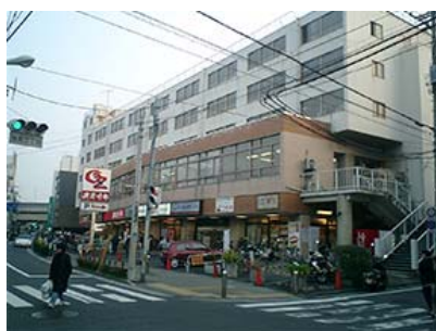
旧池尻団地の外観
