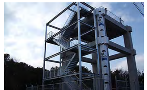
延岡市内の津波避難タワー
