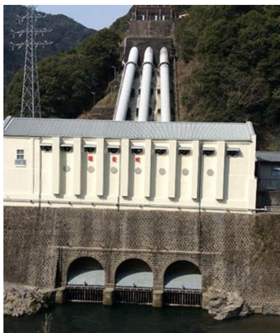
五ヶ瀬川発電所全景
